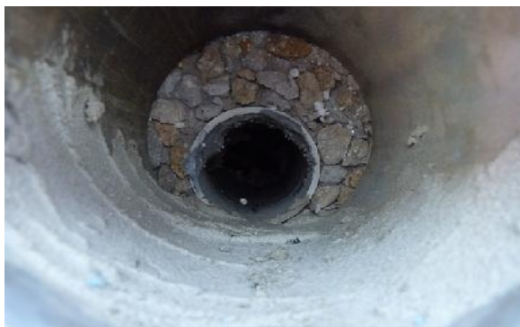
správná návaznost trubky v zateplovacím materiálu na původní větrací otvor, vymazání trubky stavebním lepidlem
